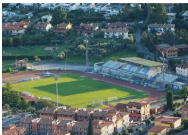
Lo stadio Lino Turina: nuova zona hospitality e impianto di atletica
